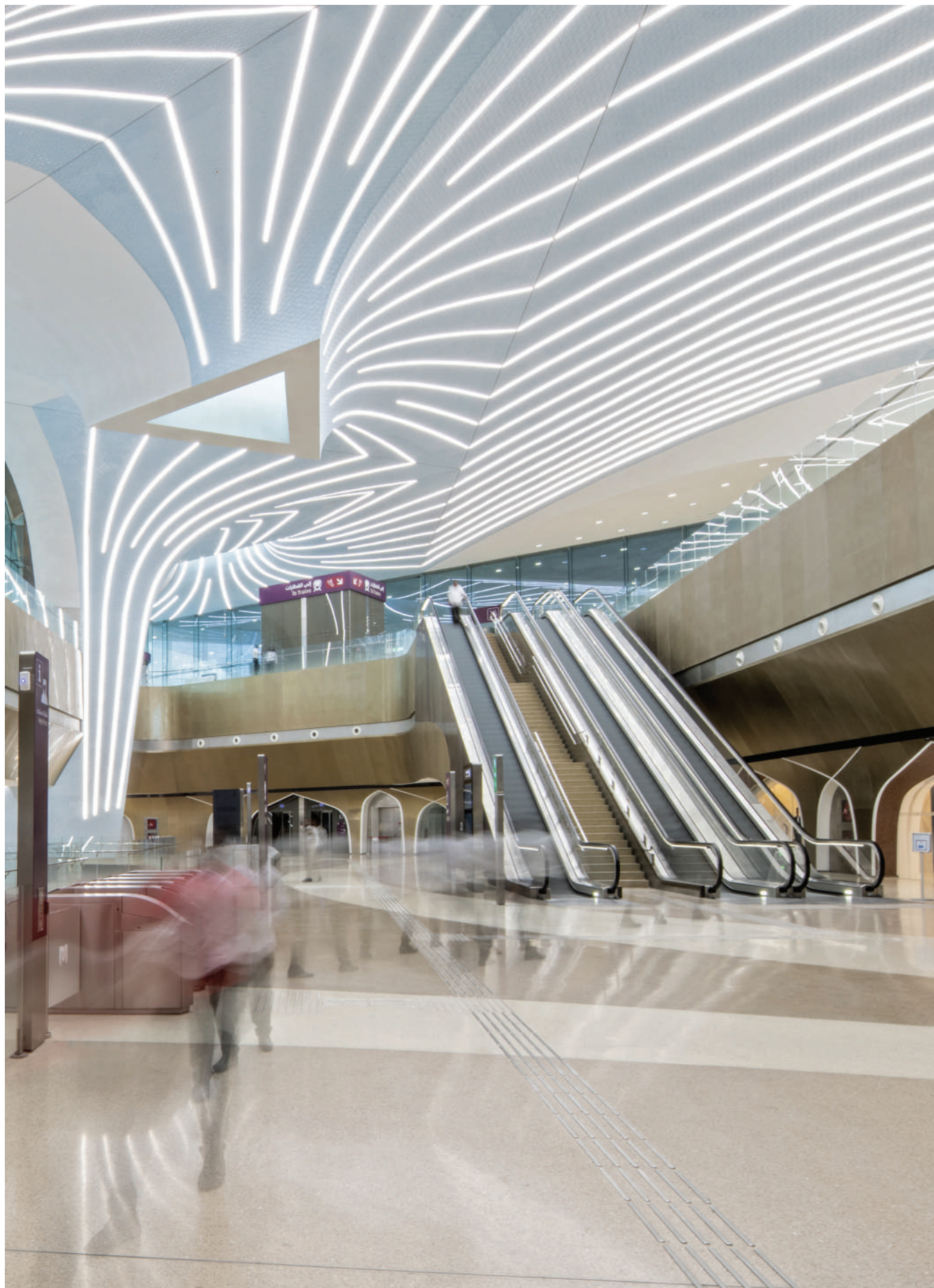
Doha Metro - Doha, Katar — Produkt: Underscore InOut Ph: Nigel Downes
